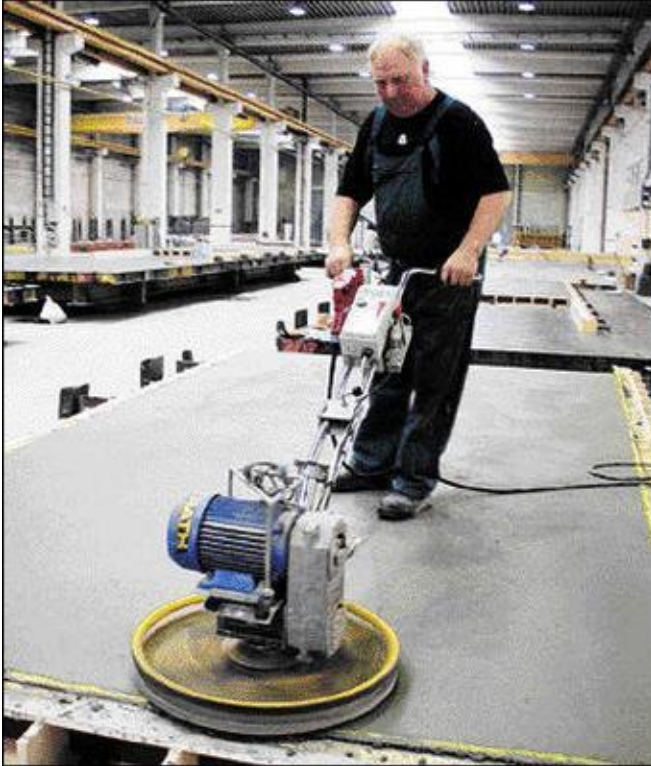
Mit einem Spezialaggregat glättet Betonbauer Fritz Stehlmann Betonplatten.
